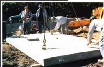
9-10-11. Movimentazione in cantiere dei pannelli prefabbricati; 12-13-14-15. Assemblaggio dei pannelli che non provengono da una produzione standard avendo ciascuno una forma originale ed irregolare.
