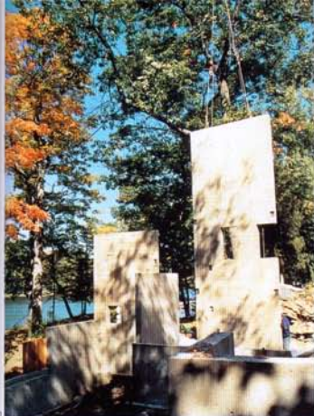
9-10-11. Movimentazione in cantiere dei pannelli prefabbricati; 12-13-14-15. Assemblaggio dei pannelli che non provengono da una produzione standard avendo ciascuno una forma originale ed irregolare.
